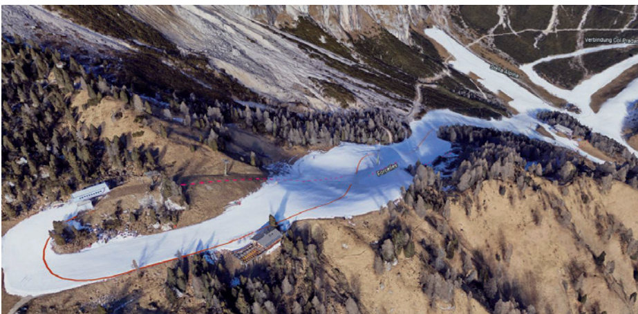
Abbildung 4: Eindruck der Geländestruktur entlang der Anlage Forcelles aus Google Earth (2)
