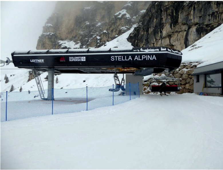
Abbildung 5: Die bestehende Bergstation Forcelles (oben) und im Vergleich dazu die jüngst erneuerte, nahegelegene Bergstation Stella Alpina, mit in den Hang integriertem Technikraum und Schaltkabine sowie flacher Dachausführung
