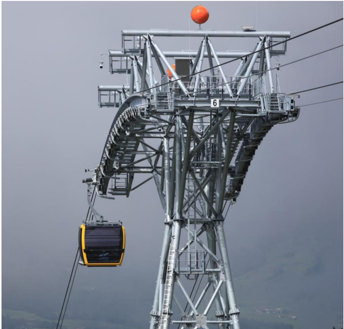
Typ Fachwerkstütze mit Rohrkonstruktion
