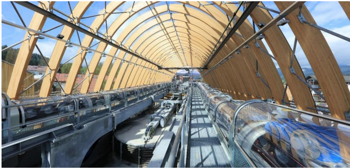
Beispiel einer seilbahntechnischen Struktur einer Station
