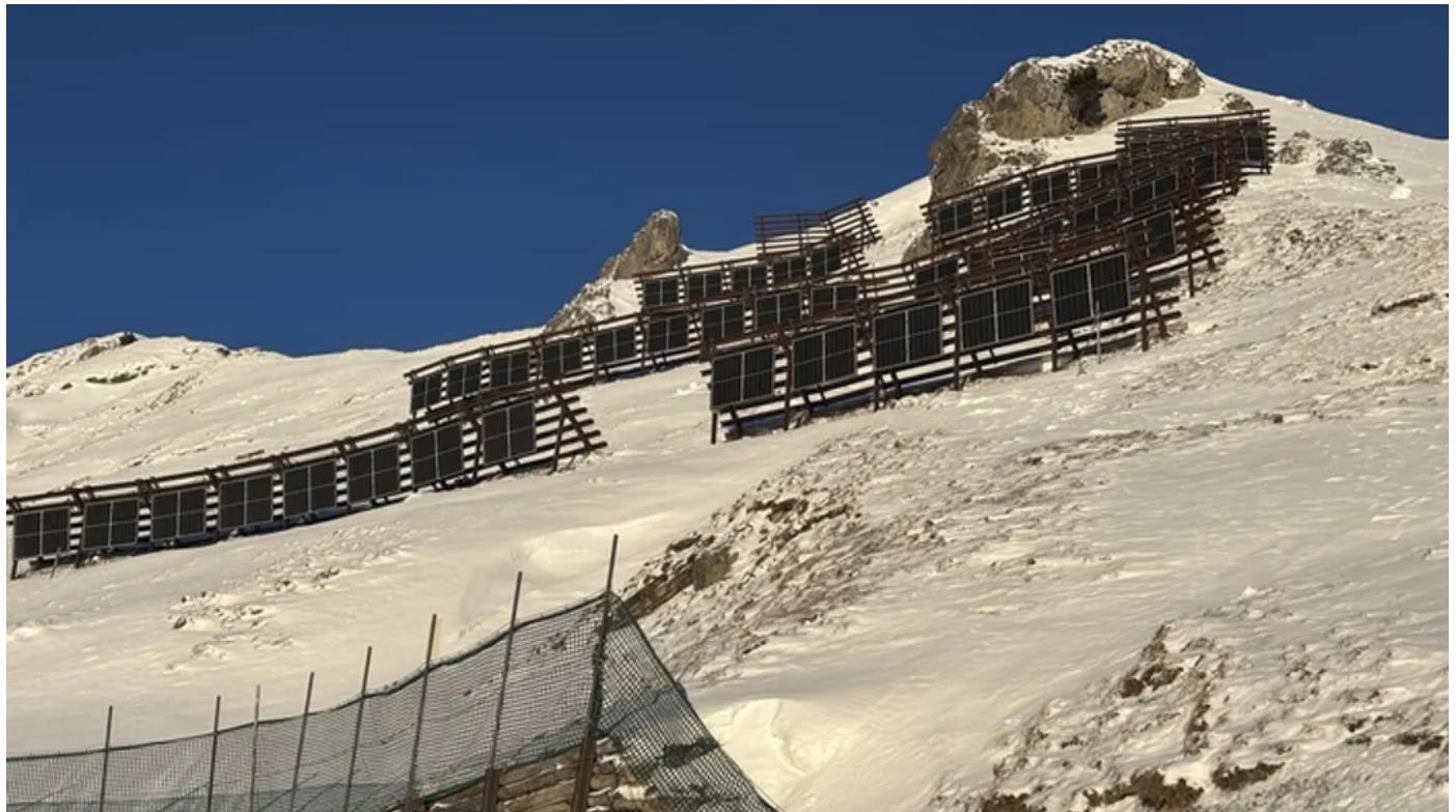
Am bereits installierten Lawinenschutz hängen neuerdings Solarpanele und liefern Strom für die Imster Bergbahnen.
